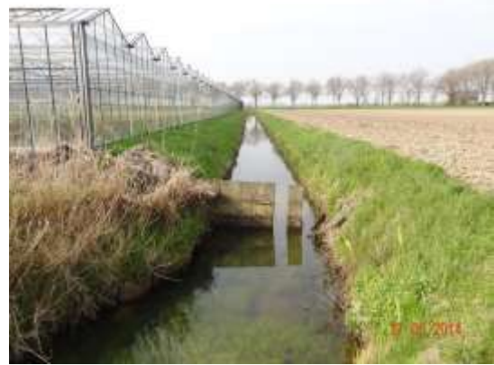
Figuur 8 Niet meer functionerende stuw onderbemaling nabij Rijksstraatweg 108
