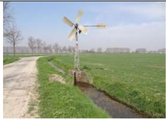
Figuur 10 Onderbemaling d.m.v. een windmolen aan de Van Elzelingenweg (peilafwijking EvD-21.AP02)
