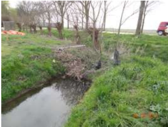
Figuur 7 Voormalige locatie pomp onderbemaling nabij Rijksstraatweg 108
