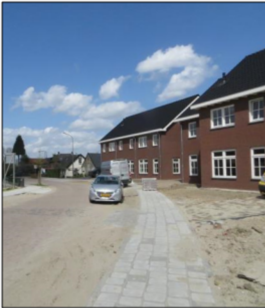
Nieuwbouwwoningen Herenland Opheusden
